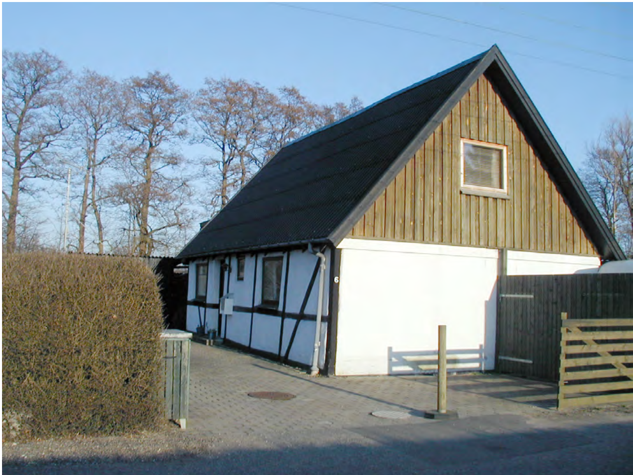
Rishavevej 6. Foto marts 2007
