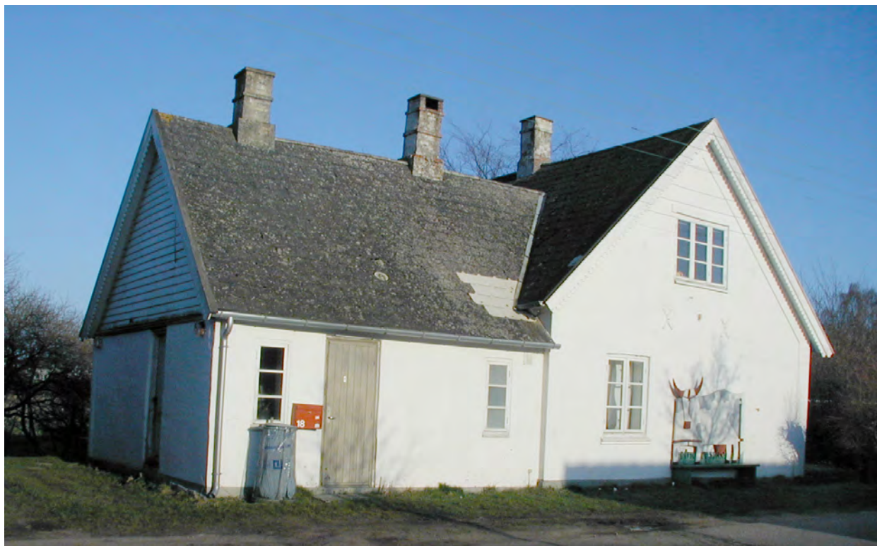
Rishavevej 18. Foto marts 2007
