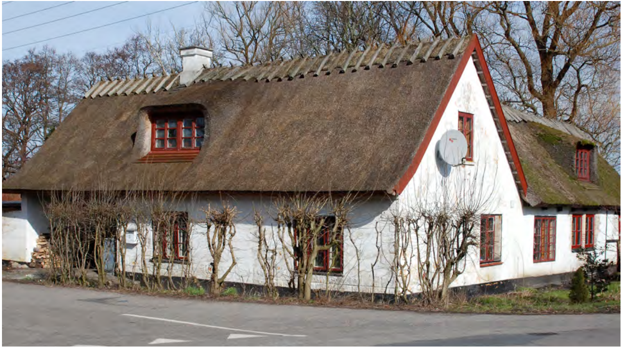
Rishavevej 2. Foto marts 2007
