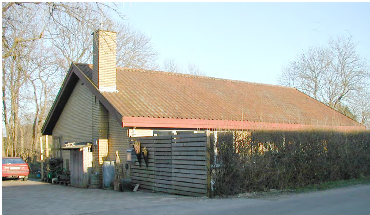
Rishavevej 24. Foto marts 2007
