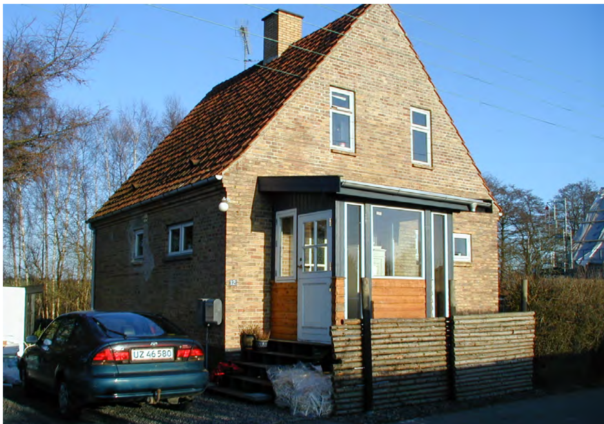
Rishavevej 12. Foto marts 2007
