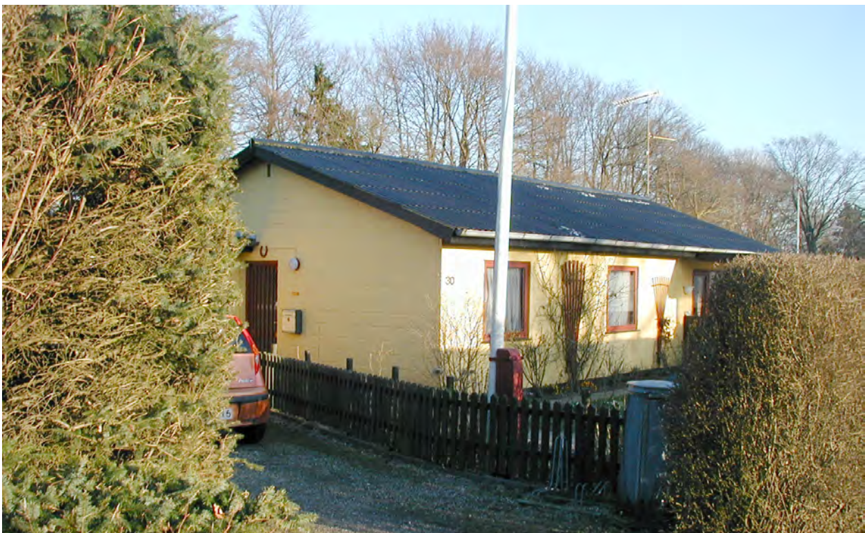
Rishavevej 30. Foto marts 2007
