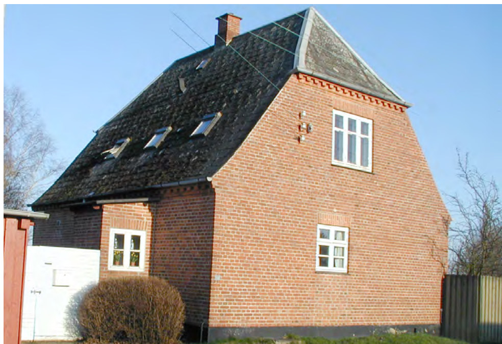
Rishavevej 16 Foto marts 2007
