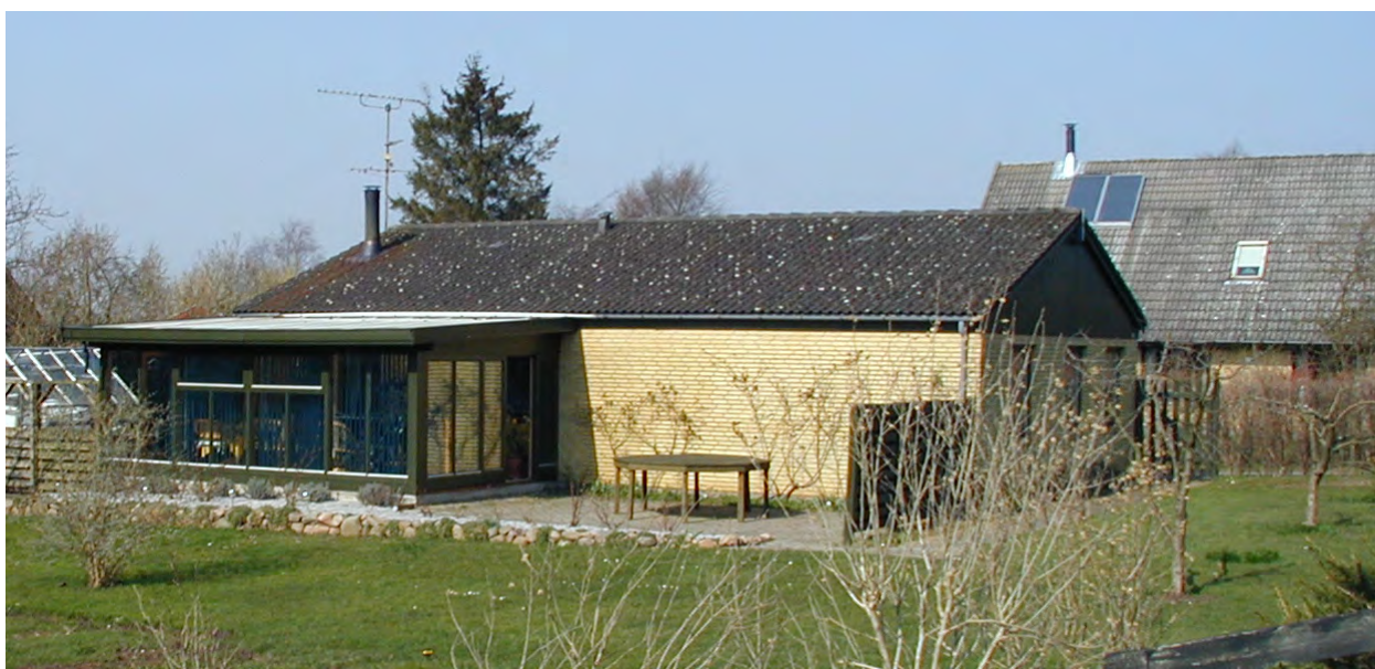
Rishavevej 7 A. Foto marts 2007
