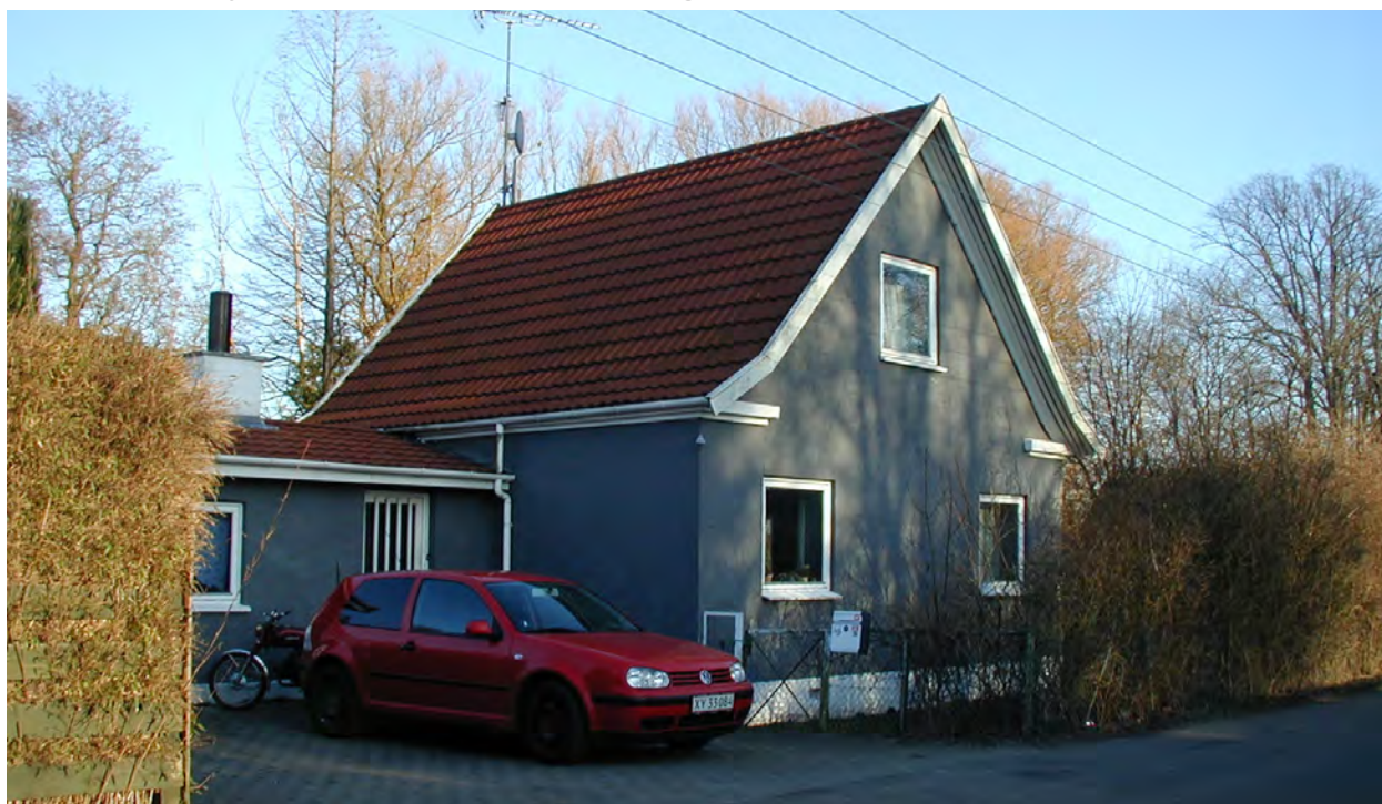
Rishavevej 4. Foto marts 2007
