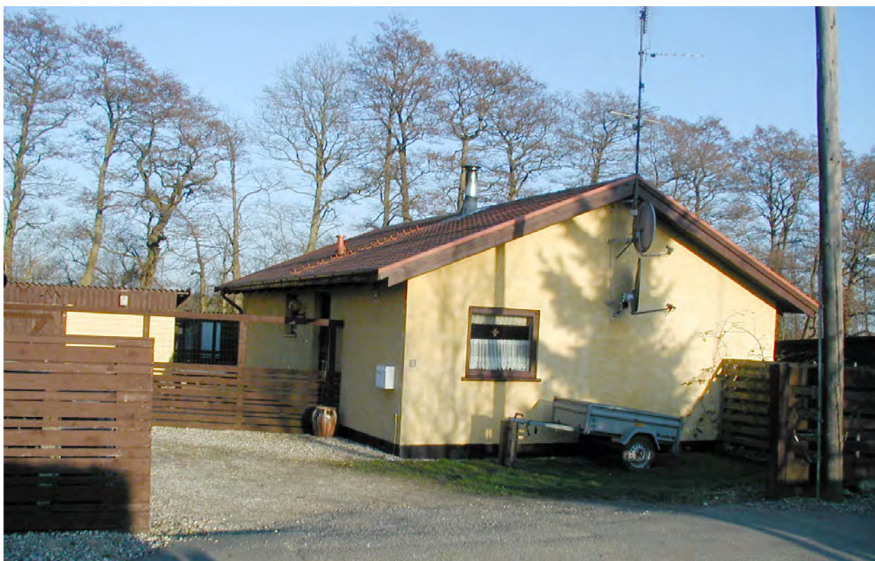
Rishavevej 8. Foto marts 2007
