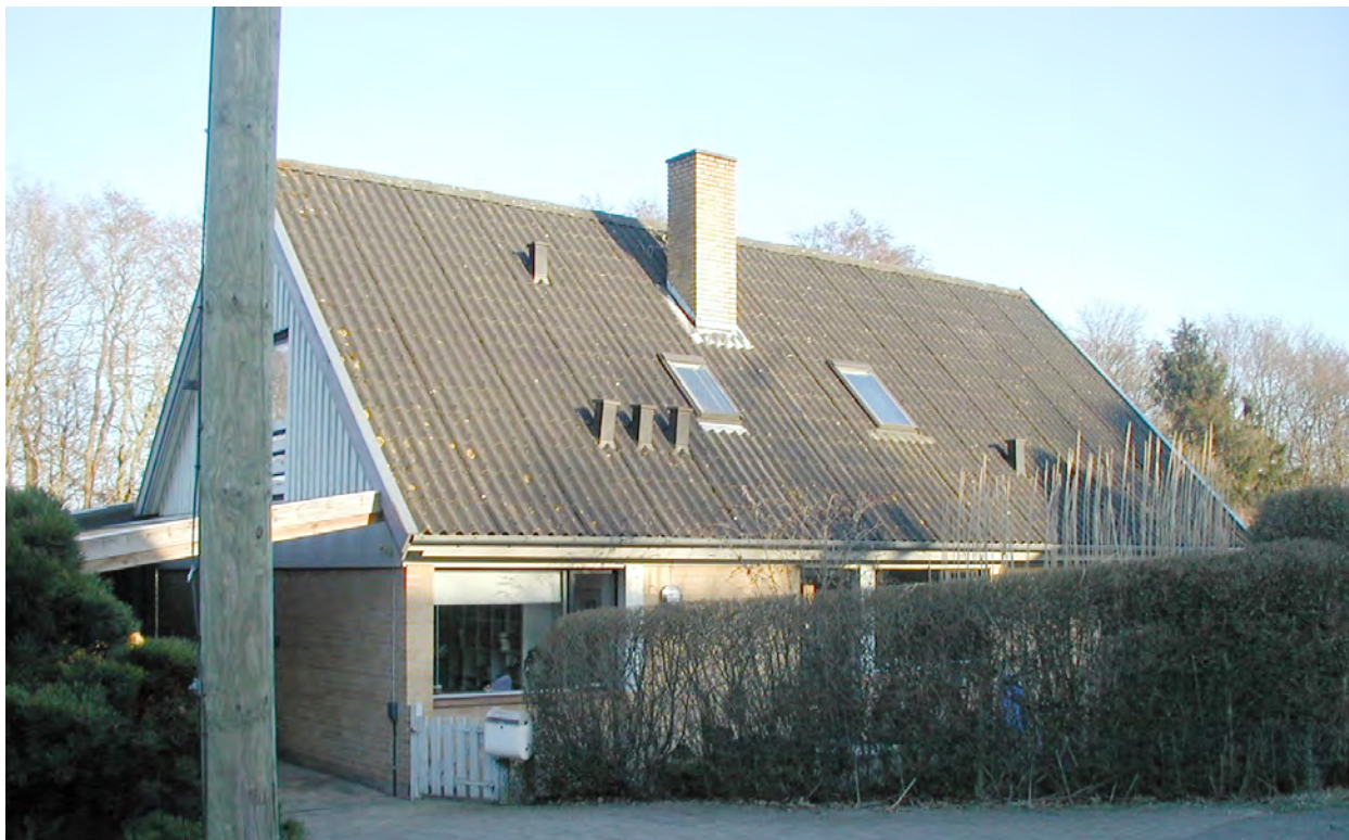
Rishavevej 32. Foto marts 2007
