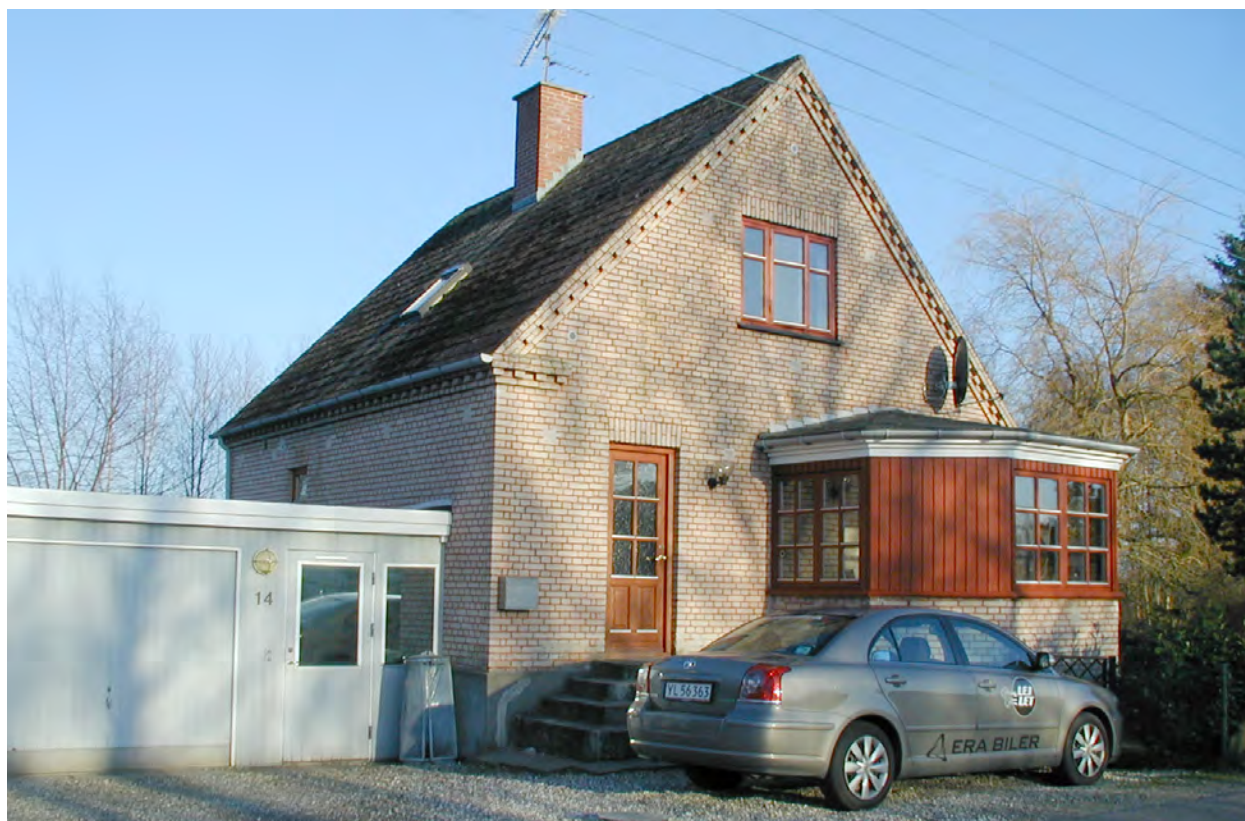
Rishavevej 14. Foto marts 2007
