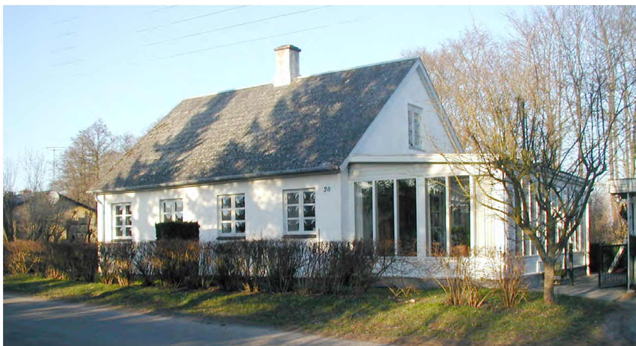
Rishavevej 28. Foto marts 2007
