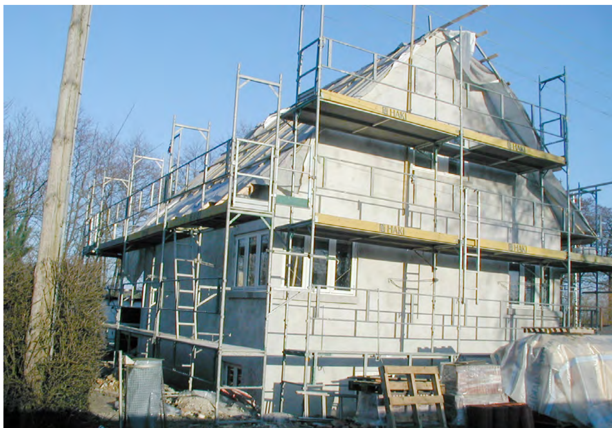
Rishavevej 10. Foto marts 2007
