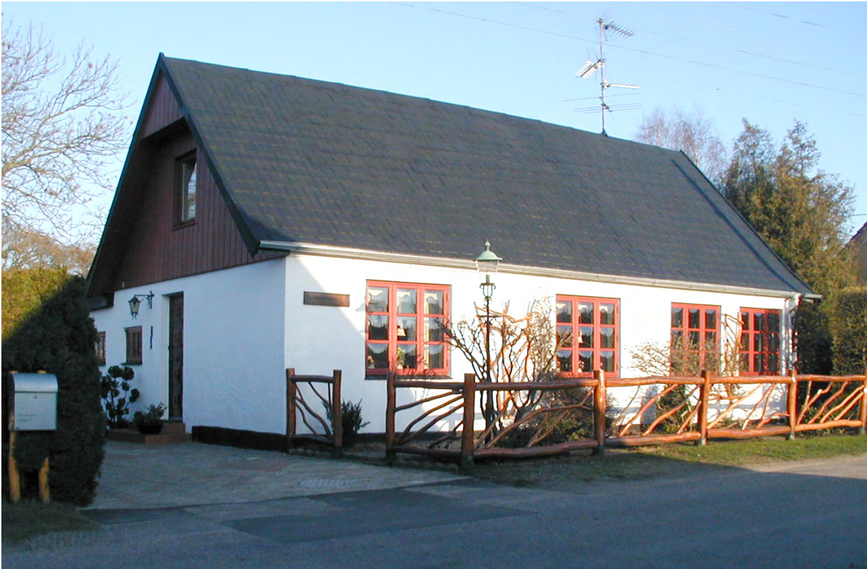
Rishavevej 22. Foto marts 2007
