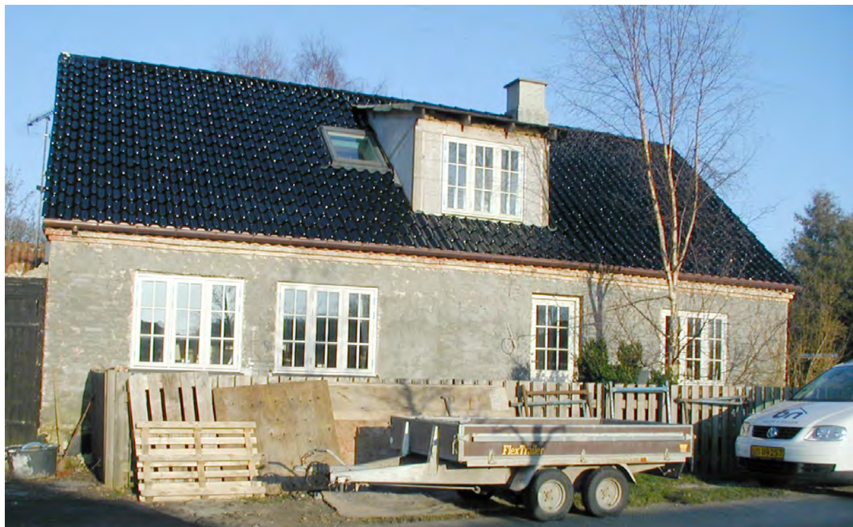
Rishavevej 20. Foto marts 2007
