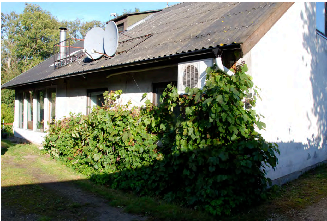
Esrum Hovedgade 11 B. Foto oktober 2009
