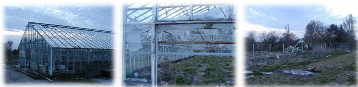
Nedrivning af drivhusene 2000-2001
